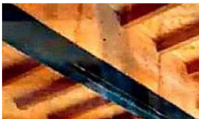
Рис. 1. Наклеивание углеволокна на нижнюю часть балки
