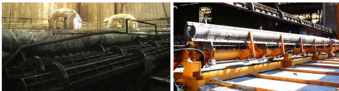
Рис. 2. Распалубка и чистка
