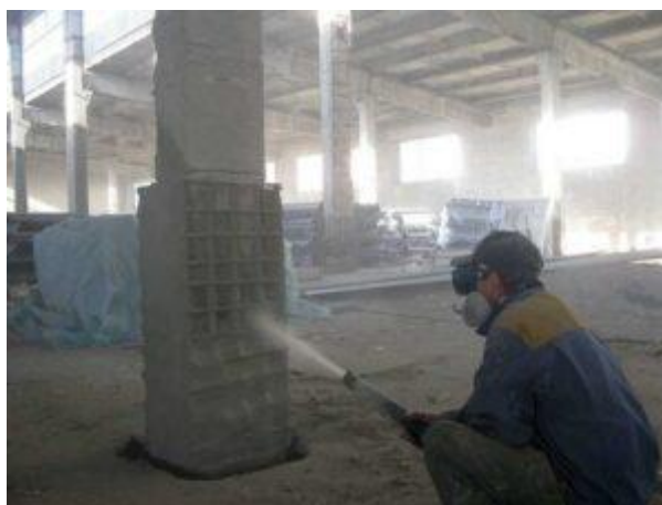
Рис.1. Ремонт колонны прямоугольного сечения методом торкретирования
